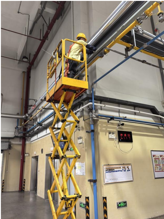
检查天然气泄漏点并处置
