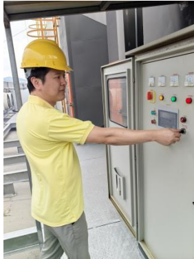
维修完成，重新运行
