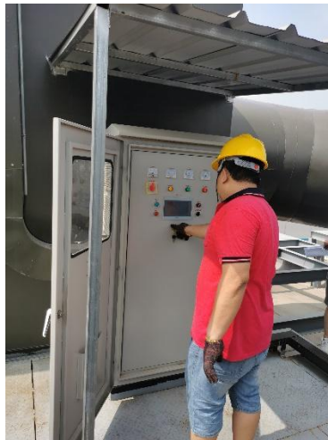
维修完成，重新运行
